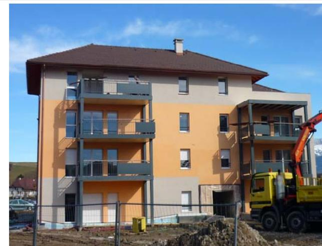
Photo 1 : Exemple de balcon autoporté
