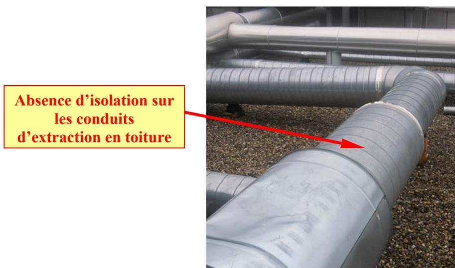
**Figure 4.2.17 : conduits d'extraction non isolés cheminant en toiture**
