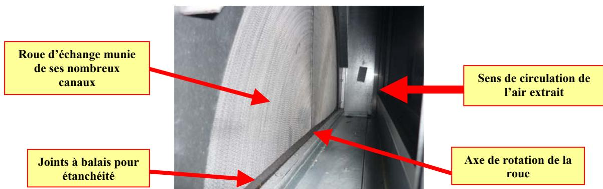
Figure 4.2.10 : Partie supérieure d'un échangeur à roue (canal de l'air extrait)
