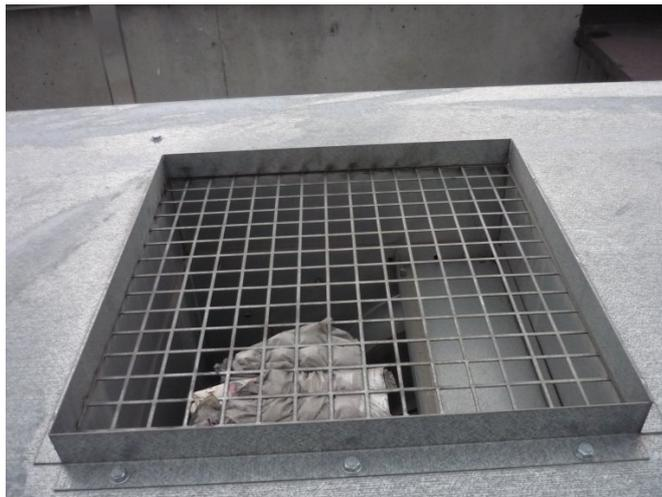
*Rejet d'air en partie obstrué par du plastique sur la cage C*
