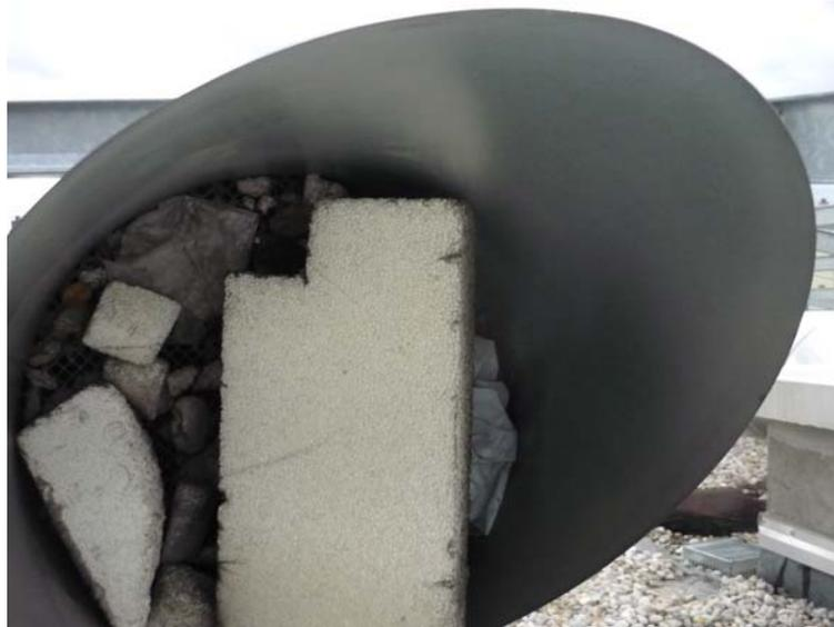
**Figure 4.2.4 : Etat d'une prise d'air située sur l'un des immeubles de la Zac de Bonne**
