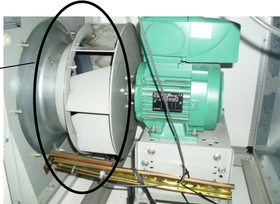
Figure A1.7 : Système de mesure du débit avec organe déprimogène
