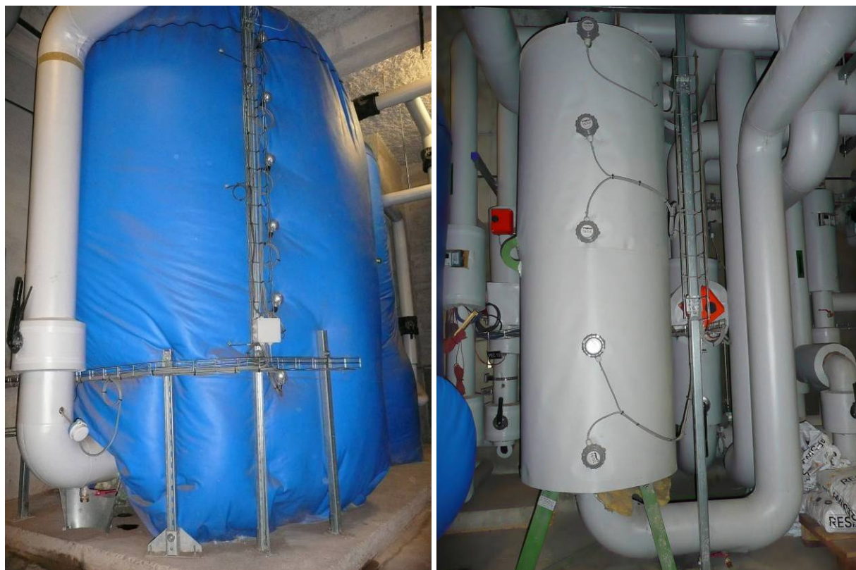
Figure 5.6.3 : Ballon tampon (8000 l) et bouteille de découplage (550 l)
