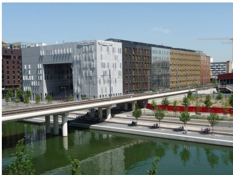
Figure 2.1.1 : Photographies de la partie tertiaire du Monolithe Haut : Façade sud – tertiaire à l'Est Bas : Façade Est
