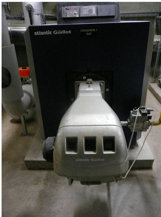
Figure 2.1.7 : Chaudière gaz et récupérateur à condensation
