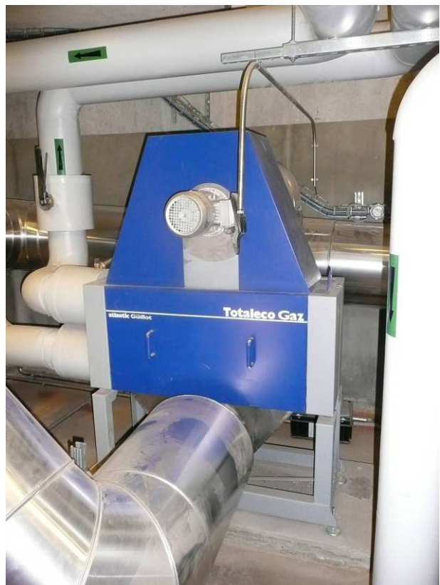
Figure 2.1.7 : Chaudière gaz et récupérateur à condensation
