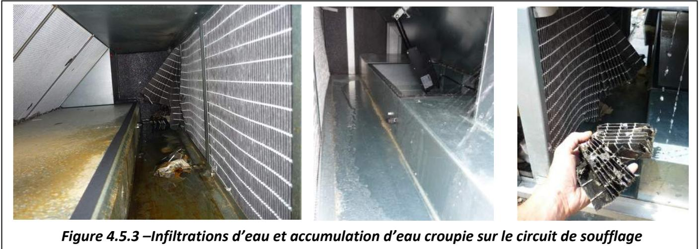
**Figure 4.5.3 – Infiltrations d'eau et accumulation d'eau croupie sur le circuit de soufflage**
