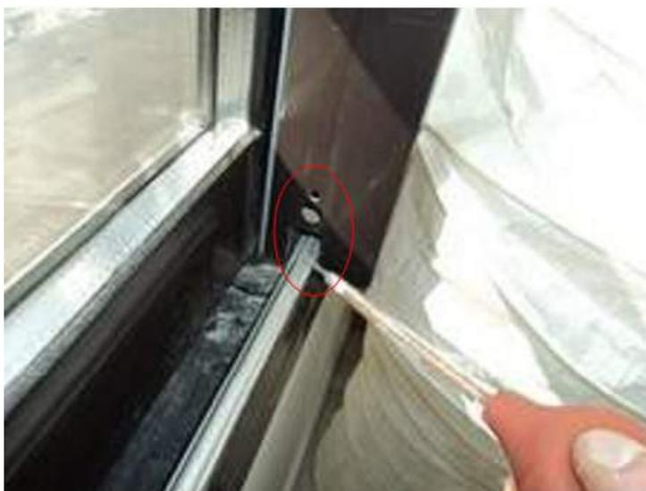
**Photographie 2.1.7 : Photographie des rails des fenêtres présentant des infiltrations**
