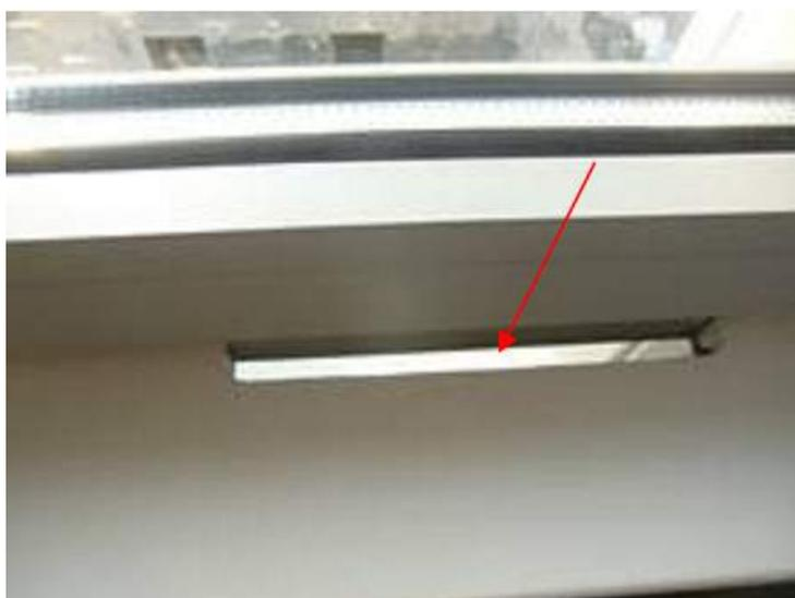
**Figure 2.1.8 : Photographie de l'ouverture réalisée dans la tablette située au niveau de l'allège de la fenêtre de cuisine**
