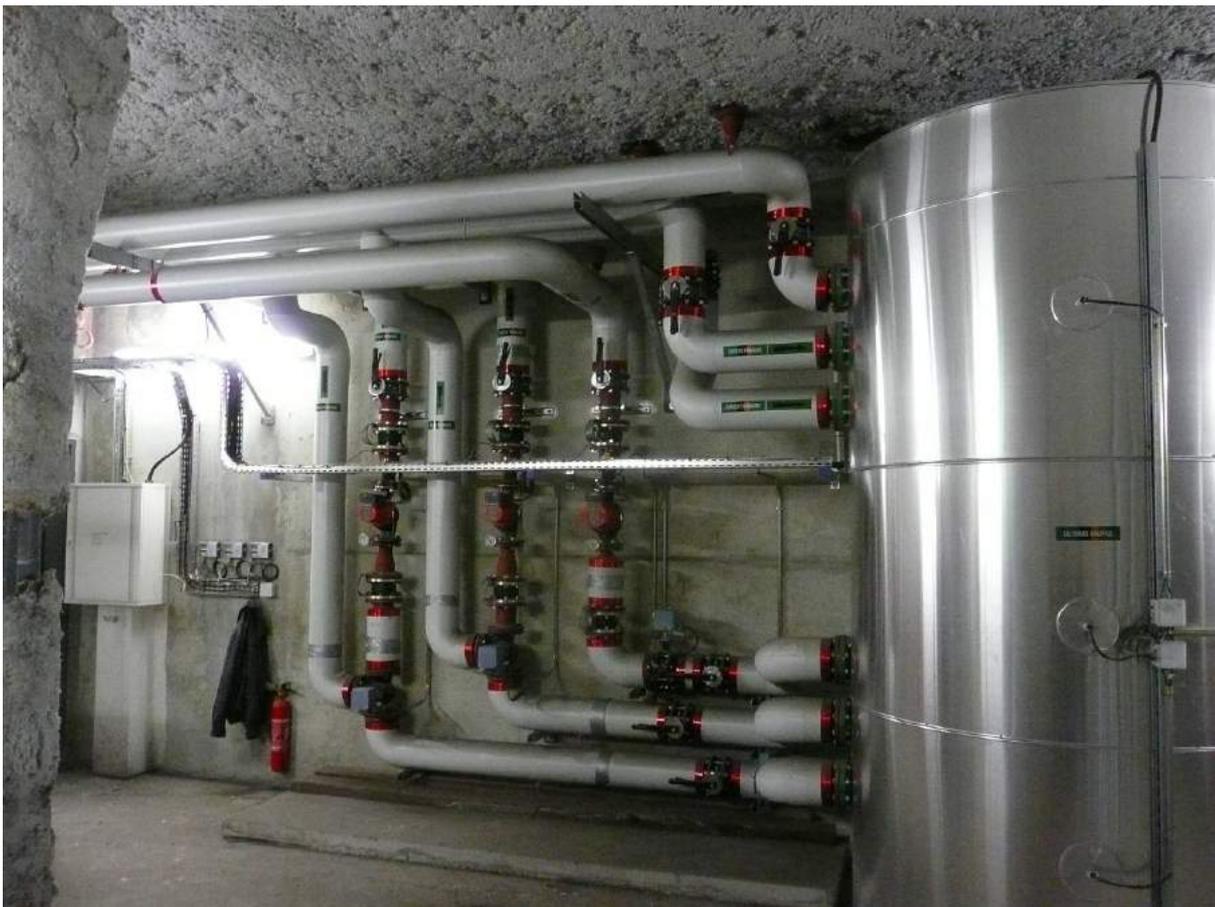
*Figure 5.1.3 : Ballon tampon et réseaux primaires (chaudières/ballon)*
