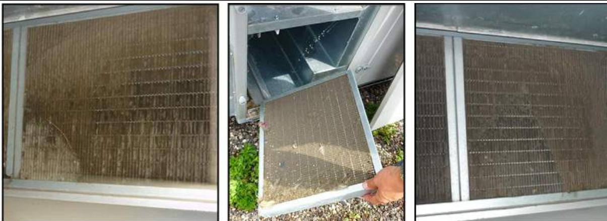
**Figure 4.5.4 – Encrassement du filtre d'air neuf**
