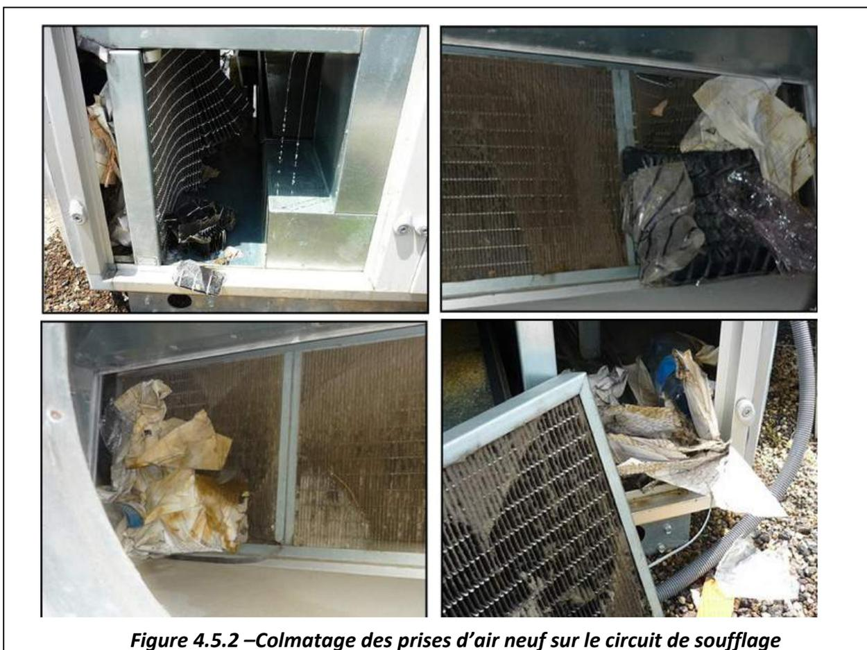
**Figure 4.5.2 – Colmatage des prises d'air neuf sur le circuit de soufflage**
