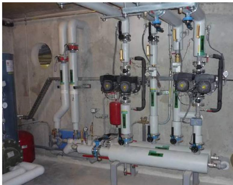
**Figure 5.1.5 : Vue d'une sous station (échangeur à l'arrière plan à gauche, pompes chauffage et eau chaude à droite)**
