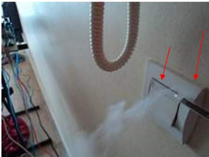
**Figure 2.1.4 : Photographie d'un interrupteur présentant des infiltrations**
