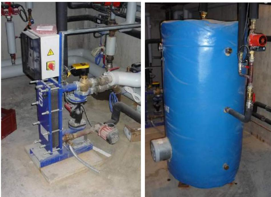
**Figure 5.1.7 : Préparateur d'eau chaude par échangeur à plaques et stockage**
