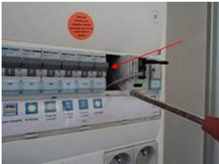
**Figure 2.1.6 : Photographie d'un tableau électrique présentant des infiltrations**
