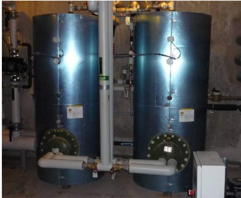
**Figure 5.1.6 : Ballons de préparation d'eau chaude à échangeur immergé**
