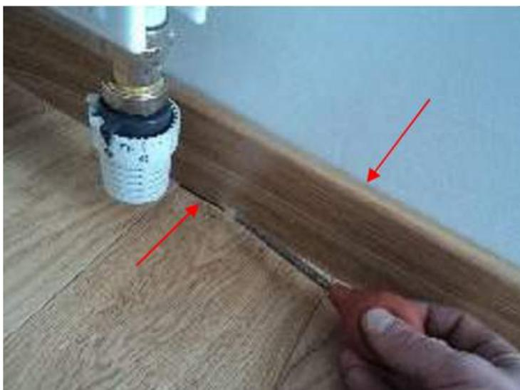
**Figure 2.1.5 : Photographie de la liaison mur/plancher – Infiltrations au niveau des plinthes**
