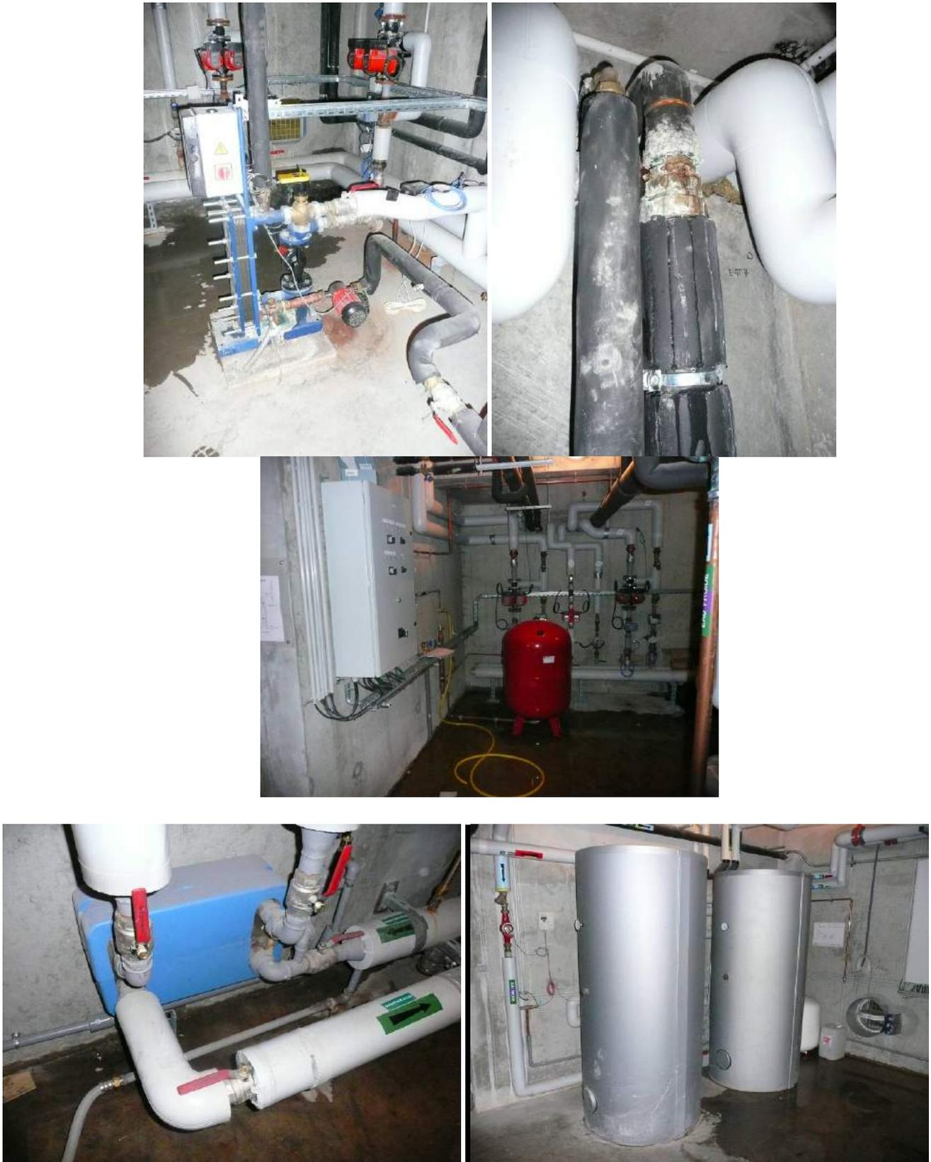
**Figure 9.1.1 : Exemples de fuites (sous-stations n°1 (2 vues), 4 (1 vue) et 6 (2 vues))**
