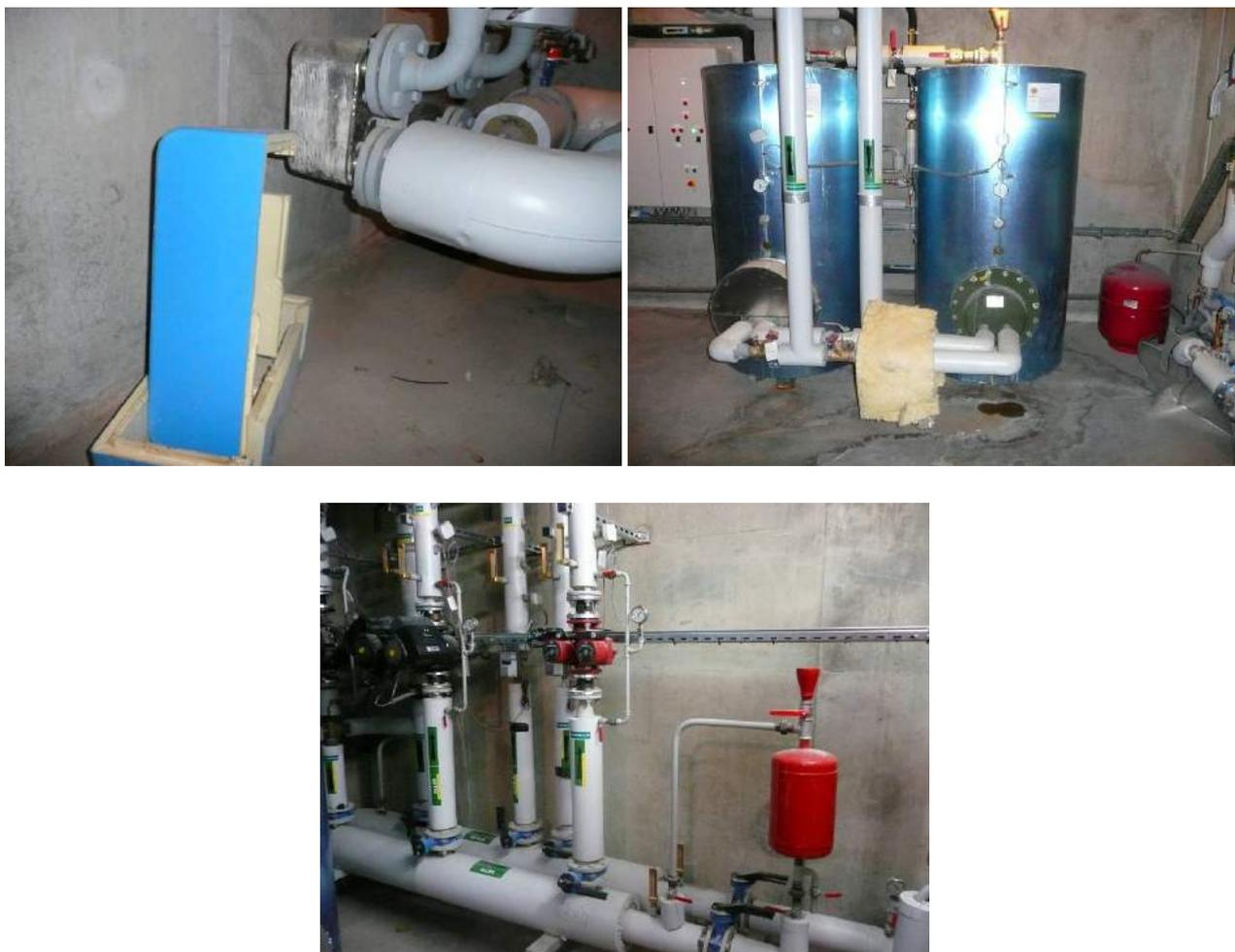
**Figure 9.1.3 : Exemples d'isolations à compléter et à remettre en place (sous-stations n° 2, 3, 5, 7 et 8)**
