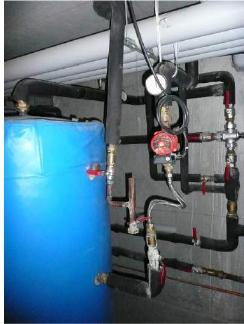
**Figure 9.1.2 : Fixation à reprendre (sous-station n°3)**
