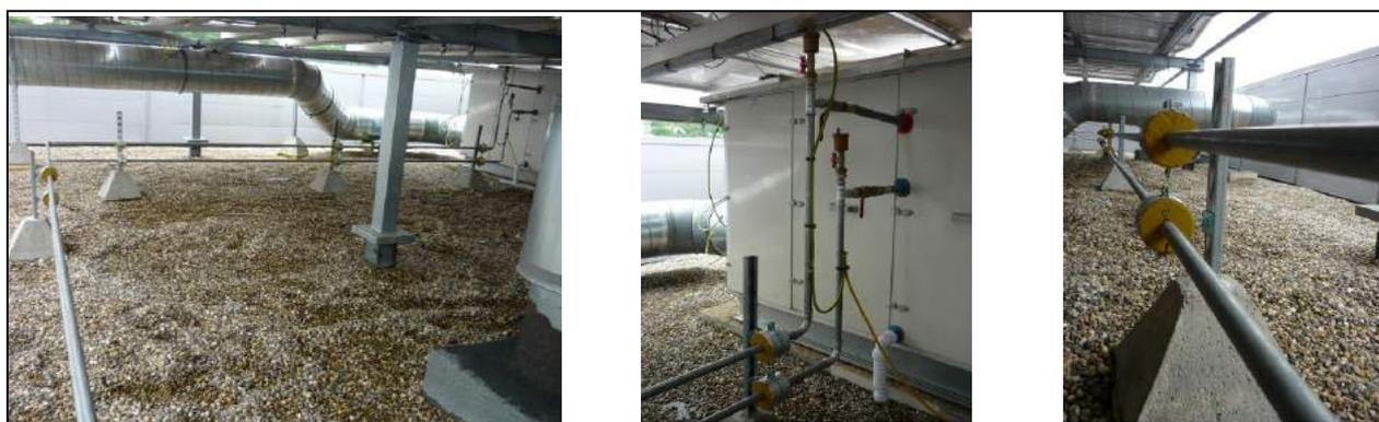
**Figure 4.5.8 – Défaut d’isolation des conduits d’alimentation des batteries chaudes**
