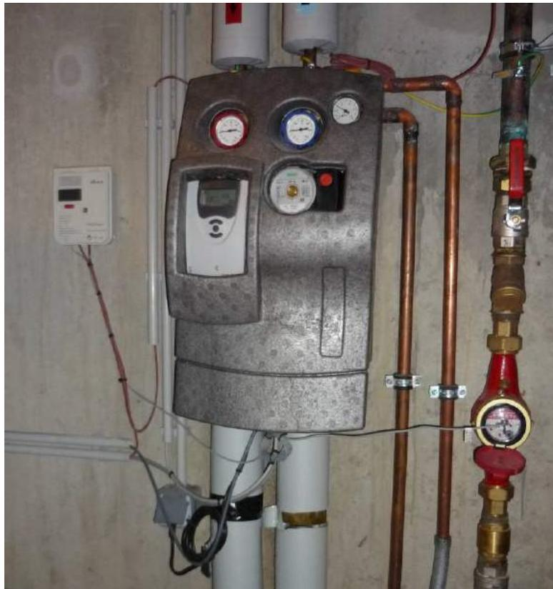
**Figure 5.1.8: Groupe de transfert pour installation solaire, avec compteur d'énergie solaire utile**
