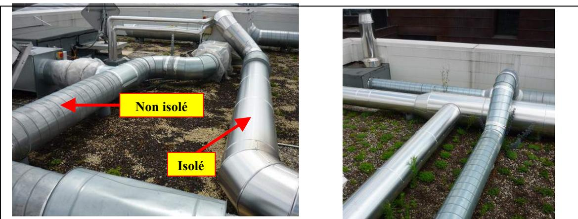
**Figure 4.5.5 – Défaut d'isolation des gaines d'extraction en toiture**
