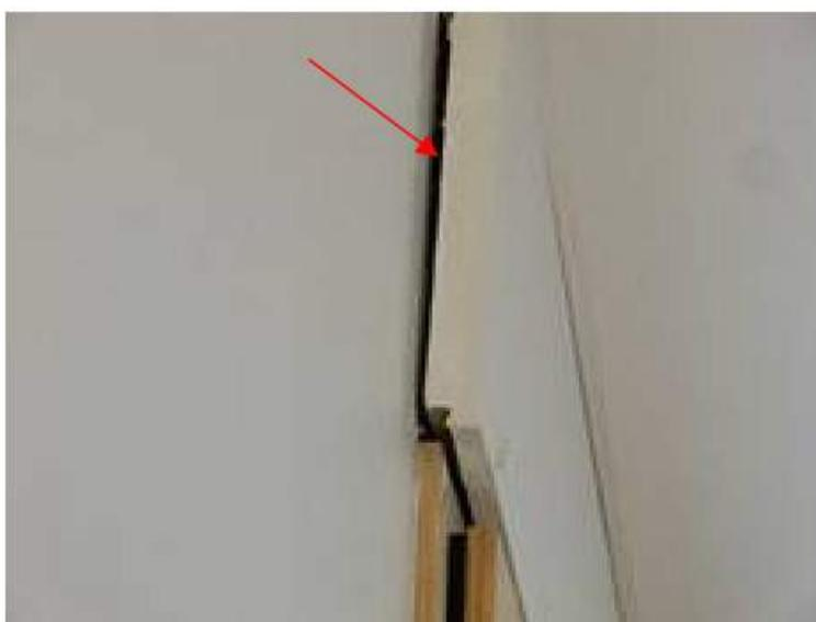
**Figure 2.1.2 : Photographie d'un coffre de volet roulant présentant une infiltration**
