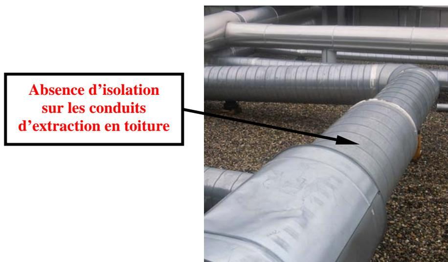
**Figure 4.2.8 : conduits d'extraction non isolés cheminant en toiture**
