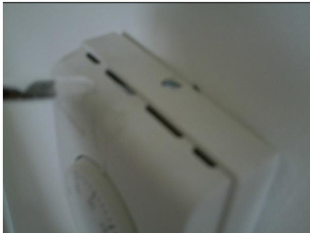
*Figure 2.1.1 : Fuite d'air au niveau des thermostats. Photo issue du rapport du test intermédiaire d'infiltrométrie.*
