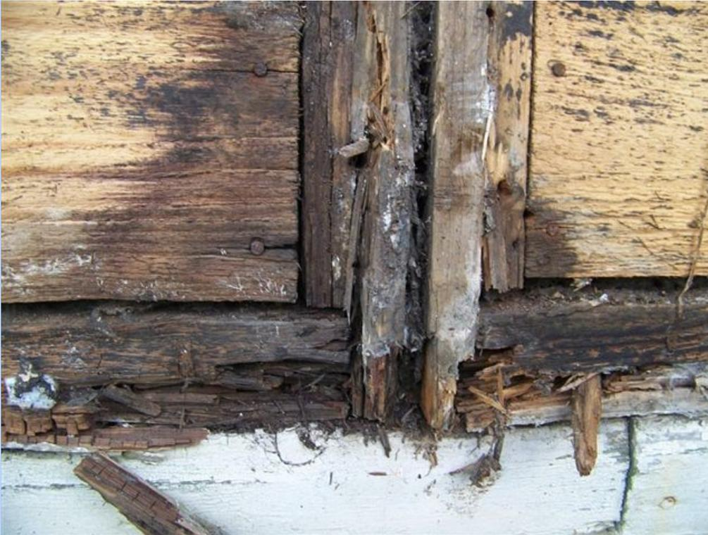
Les défauts d'étanchéité laissent passer de l'air chaud qui se refroidit dans les murs en condensant la vapeur d'eau.
