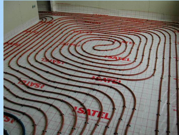
Cette solution permet à la fois de chauffer en hiver et de refroidir en été. Les consommations sont minimisées dans les deux cas. Ce faisant, on régénère en été le sol refroidi en hiver.
