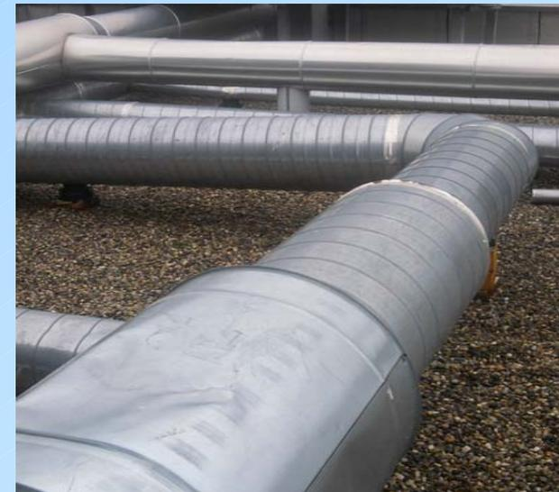
L'absence de calorifuge à l'extraction fait chuter la température de l'air à l'entrée de l'échangeur, et réduit l'énergie récupérée, ce qui augmente la consommation de chauffage
