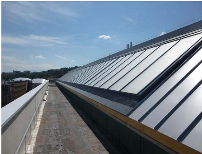
130 m<sup>2</sup> de capteurs solaires pour la production ECS
