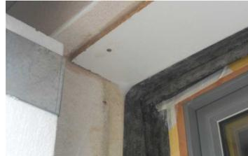
Membranes butyl entre maçonnerie et nouvelles menuiseries
