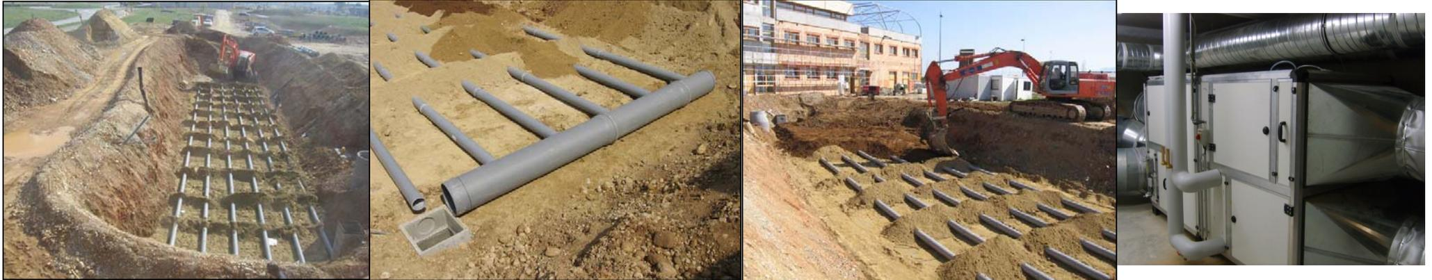
Puits canadien constitué de deux nappes de 240 m chacune de canalisations enterrées à 2,5 et à 1,5 m de profondeur
