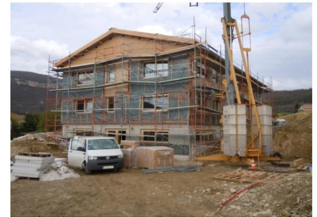
... les murs préfabriqués apportés par camion et assemblés à la grue par panneaux de 4 à 5 m de long et de hauteur d'étage.
