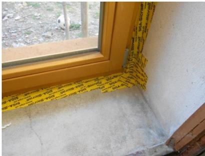
3 – Très forte étanchéité à l'air des logements, vérifiée par le test à la porte soufflante
