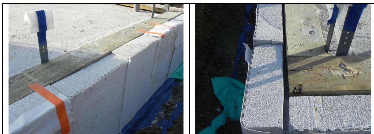
Isolation des soubassements par 188 mm de polystyrène expansé
