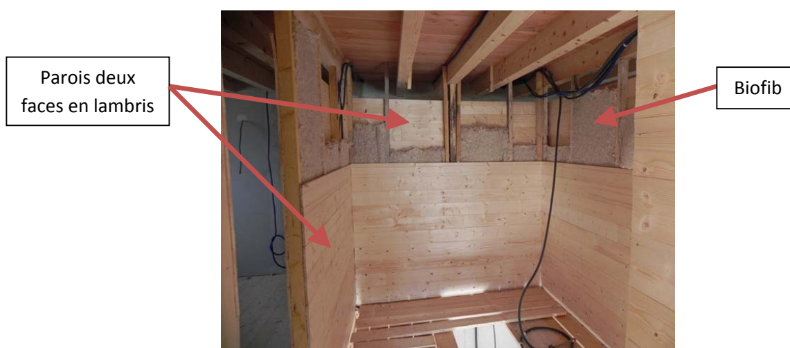
Cloisonnement sur la cage d'escalier
