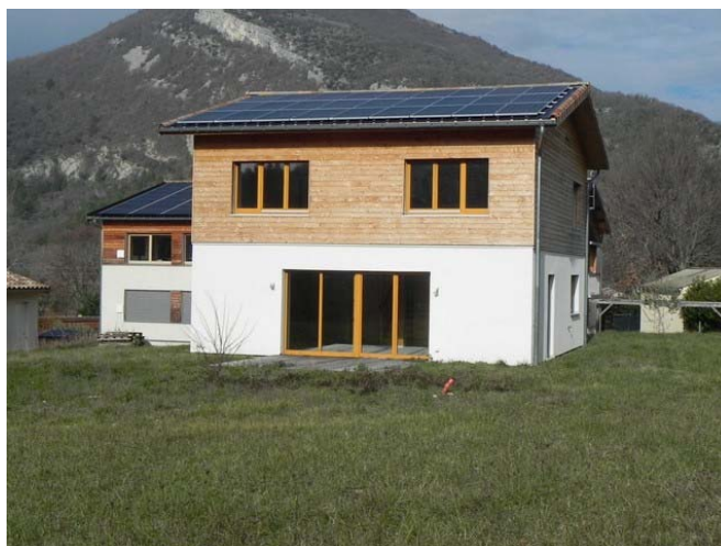
La toiture sud est recouverte de 45,5 m 2 de panneaux photovoltaïques
