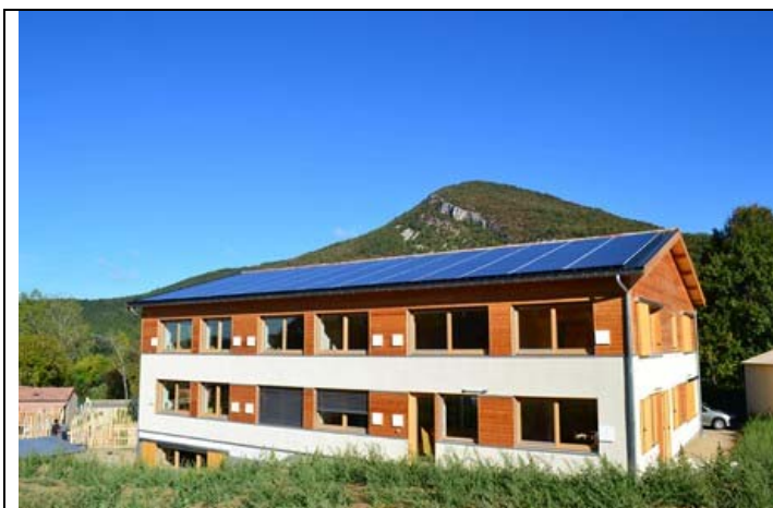
Façade Sud des locaux d'ENERTECH (les carrés blancs sont les prises et rejets d'air de la ventilation double flux décentralisée par bureau)
