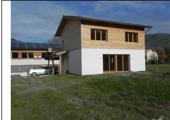
Façade sud et ouest – A l'arrière les bureaux d'Enertech
