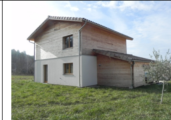
Façades nord et est
