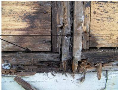
Fig. 1 : Pourrissement du bois dû aux exfiltrations d'air dans une maison à ossature bois
