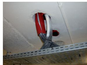
Fig. 9: Fourreaux et réservation non traités entre rez-de-chaussée et sous-sol
