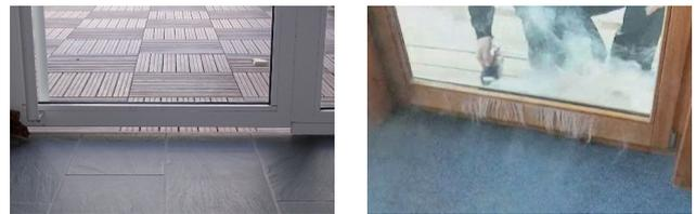
Fig. 6: Étanchéité à l'air des portes extérieures
