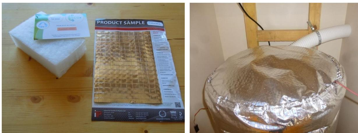
**Figure 49 : Jaquette isolante Isosten, fabriquée sur mesure**
