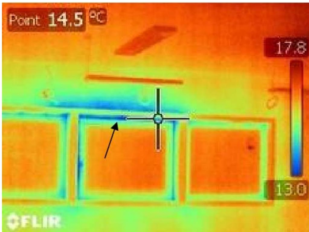
*Figure 2.1.1 : Une des nombreuses petites infiltrations au niveau des menuiseries, ici au 4<sup>e</sup> étage côté boulevard Gambetta.*
