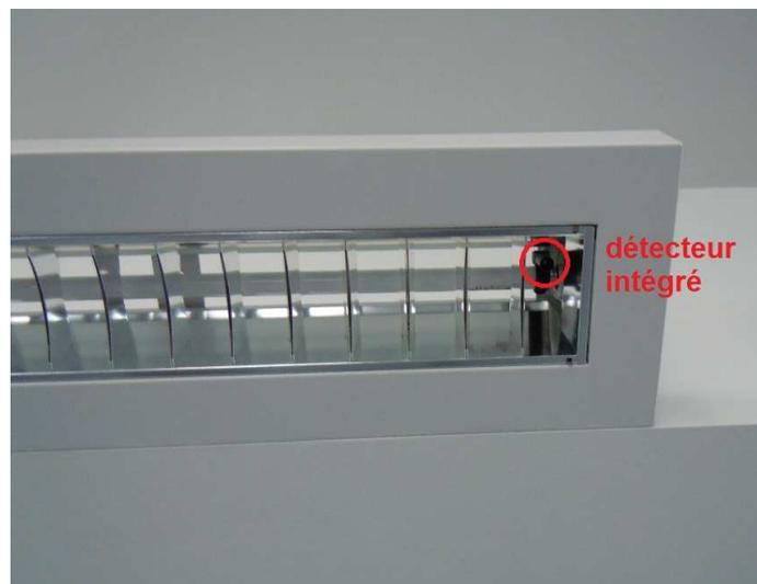
**Figure 9.5.7 : Détecteur de luminosité intégré au luminaire**
