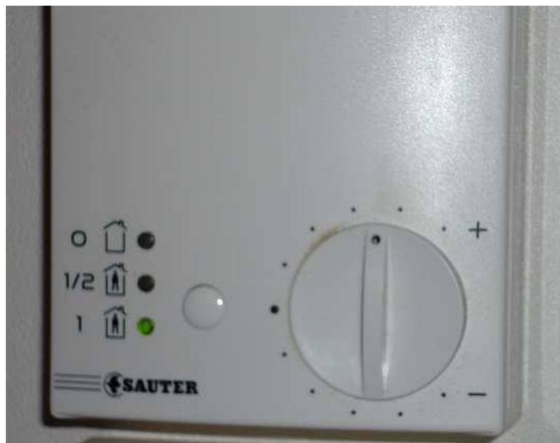
**Figure 7.3.2 : Photographie de la commande de régulation terminale**
