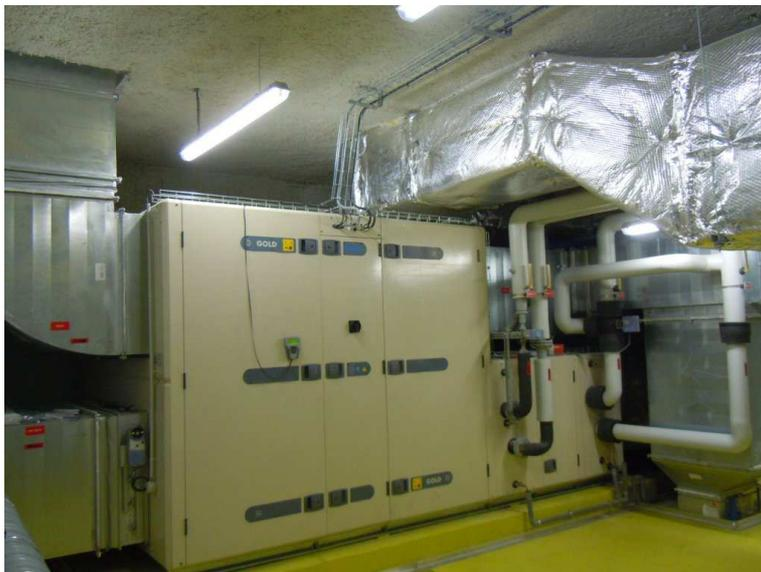
**Figure 2.1.4 : Photographie de la CTA double flux des bureaux**
