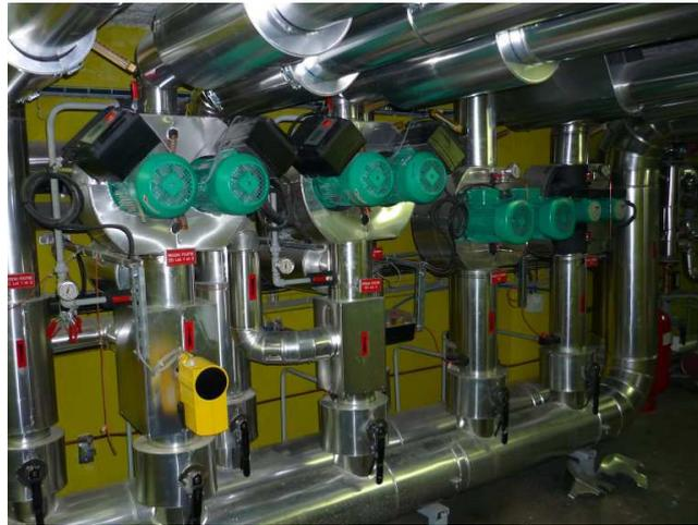
**Figure 2.1.7 : Photographie de l'échangeur de chaleur (haut à gauche), de la bouteille de découplage (haut à droite) et d'une partie de la panoplie hydraulique (bas)**
