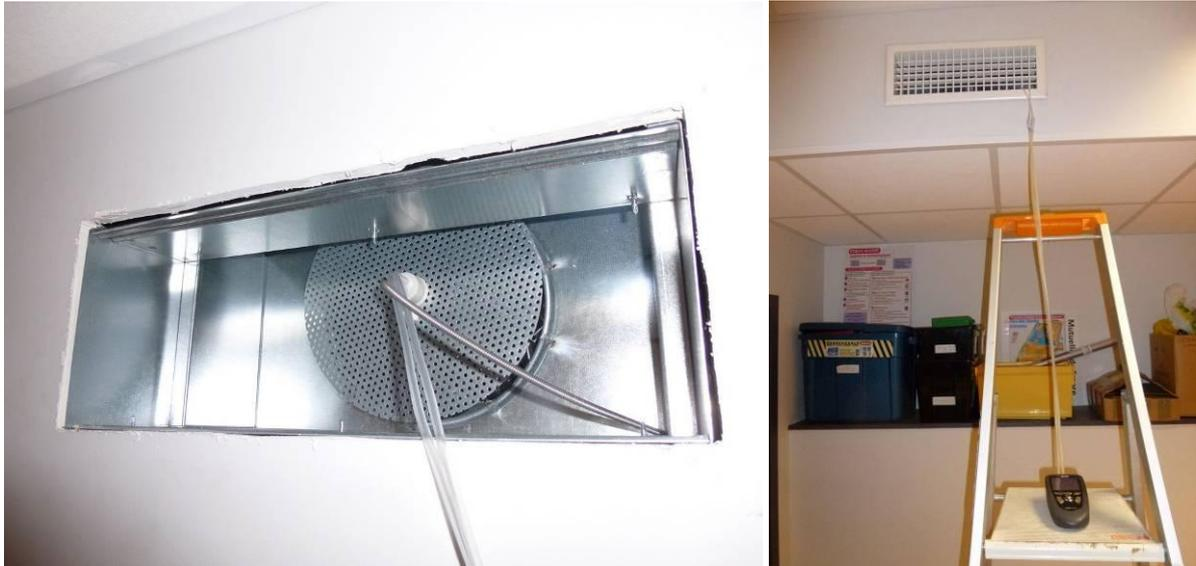
**Figure 5.12 : Mesures des débits aux grilles de ventilation**
