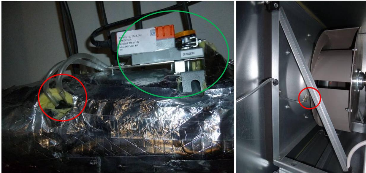
**Figure 1.5 : Mesure (○) et réglage du débit (○) dans les salles de classes (à gauche) et mesure du débit (○) sur un ventilateur de la CTA (à droite)**
