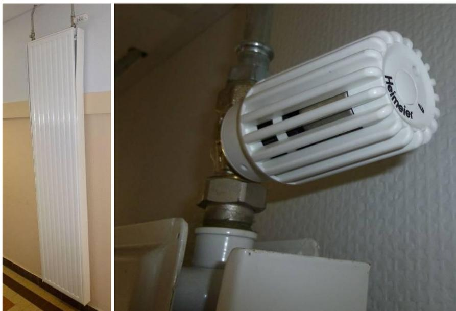
**Figure 6.11 : Radiateur dans un couloir avec son robinet thermostatique**
