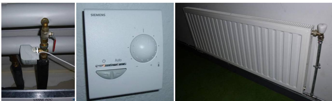
**Figure 6.7 : Vanne de zone avec son micromoteur, thermostat d'ambiance avec modulation de température et radiateur avec robinet simple.**
