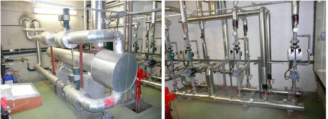
**Figure 1.6 : Photographie de l'échangeur chauffage urbain (gauche) et de la sous-station (droite)**
