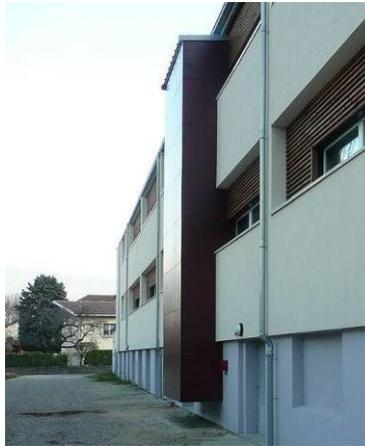
**Figure 6.4 : Caisson de passage des gaines de soufflage et reprise d'air sur la façade Nord de l'école**
