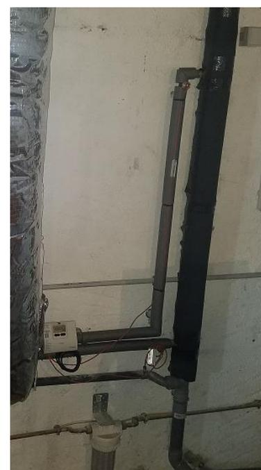
Installation finalisée avec calorifuge
