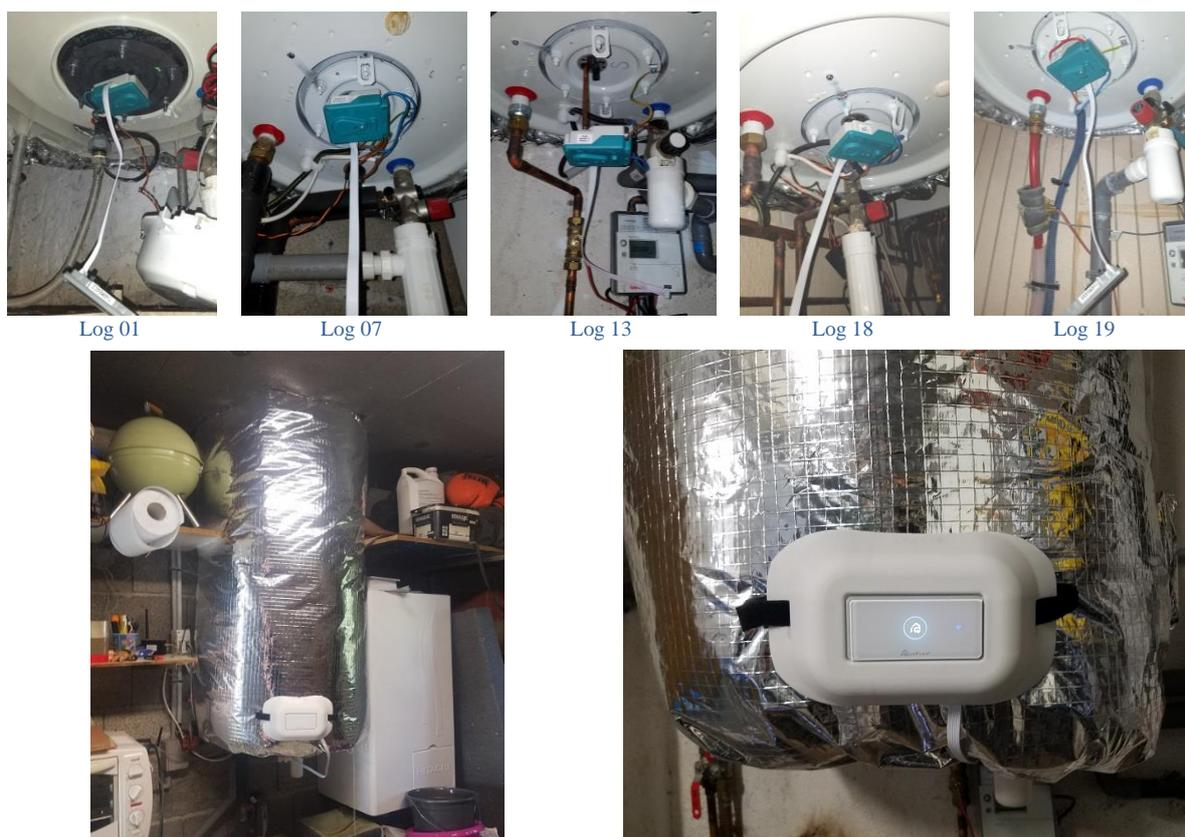
Figure 29 : Installations des thermostats électroniques connectés Cotherm.
