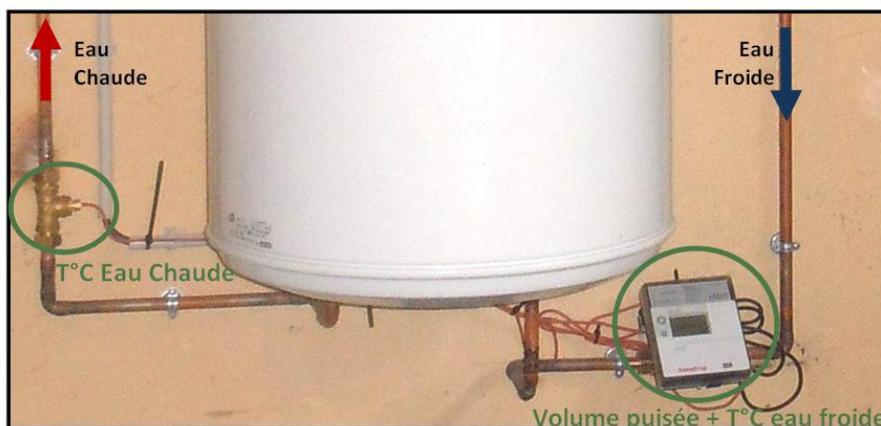
Figure 2 : Mise en œuvre du compteur de chaleur Multical 402 de Kamstrup.
