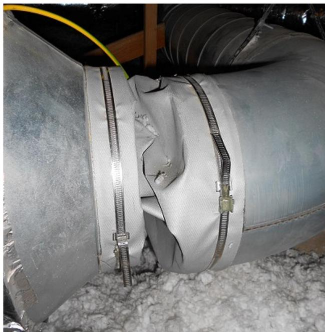
**Figure 4.6.3 : Manchette souple sur l'arrivée d'air neuf (cage D angle)**
