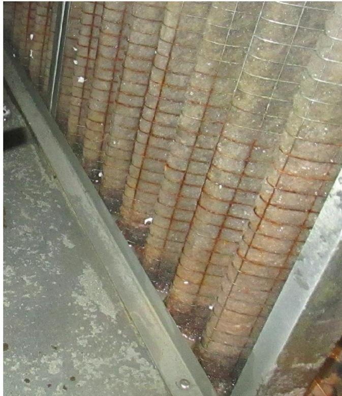
**Figure 4.6.2 : Rouille sur le filtre extrait de la CTA de la cage A**
