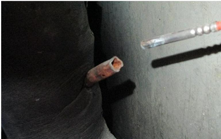
*Figure 6.1.2 : Photo du doigt de gant et de la sonde de température*
