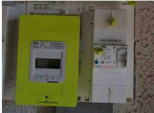
Figure 185 : Illustration – Exemple de compteur Linky.
