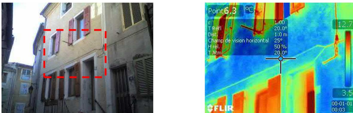
Figure 79 : Thermogramme extérieur de mur isolé par l'intérieur, au niveau du plancher intermédiaire bois.
