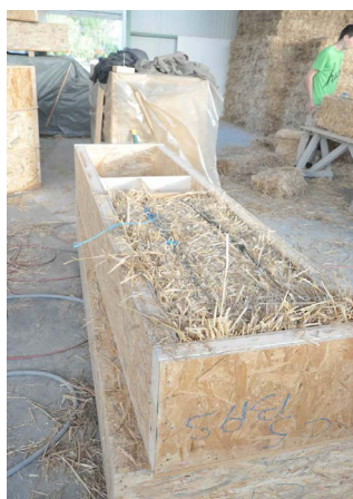
Préfabrication en atelier des caissons bois- paille
