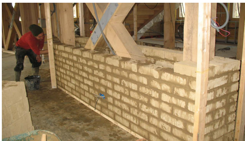
Chantier : réalisation du mur en briques de terre crue issue du terrain, monté autour des croix de Saint-André
