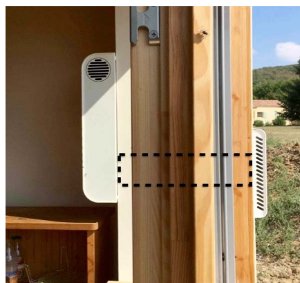
Caisson de ventilation décentralisée avant pose
