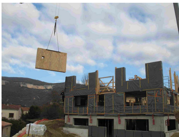
Chantier : grutage d'un panneau préfabriqué
