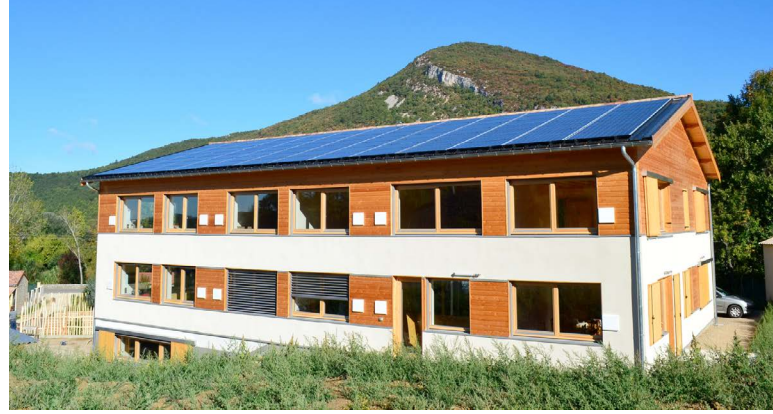
Toiture photovoltaïque au sud
