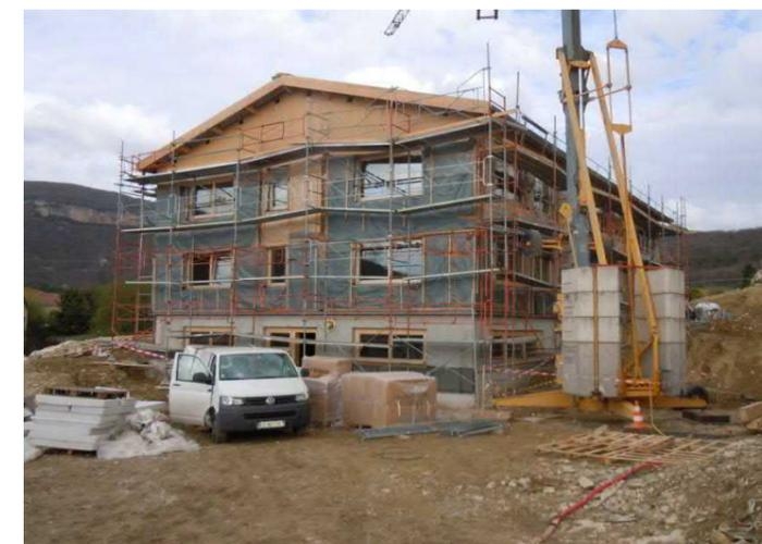
... les murs préfabriqués apportés par camion et assemblés à la grue par panneaux de 4 à 5 m de long et de hauteur d'étage.
