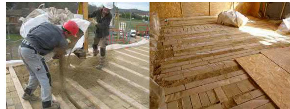
Remplissage des planchers en briques d'argile crue (rebut).
