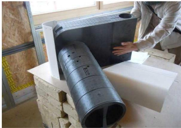
Le caisson et le conduit permettent d'aspirer l'air neuf et rejeter l'air extrait **à travers le mur**.
