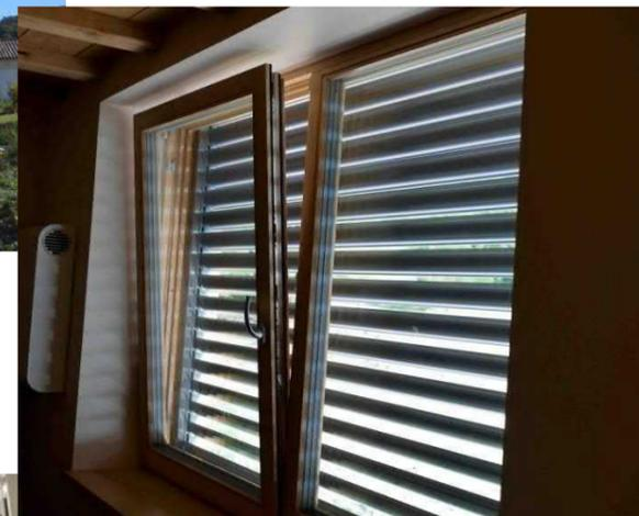
Aération nocturne : nous laissons entrer la fraîcheur la nuit avec les fenêtres oscillo-battantes. Les BSO assurent la protection contre la pluie et l'intrusion.
