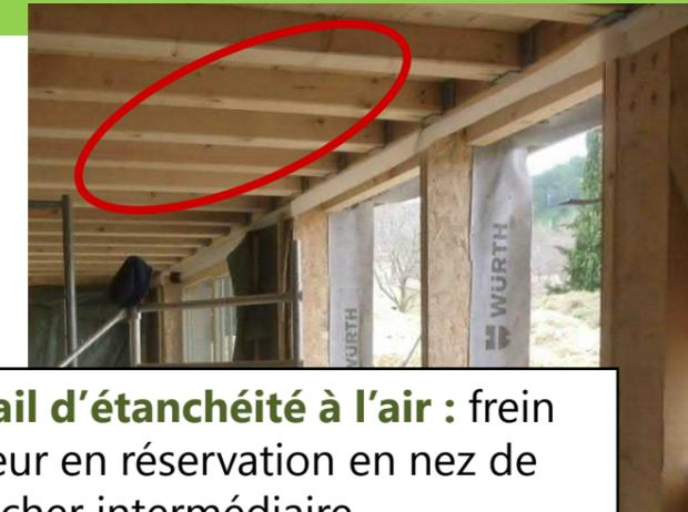
**Détail d'étanchéité à l'air** : frein vapeur en réservation en nez de plancher intermédiaire
