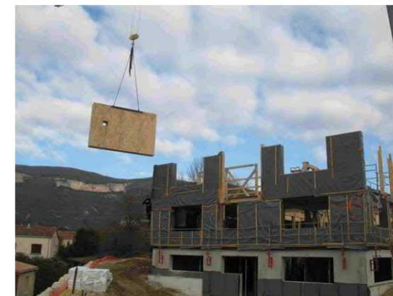
Chantier : grutage d'un panneau préfabriqué
