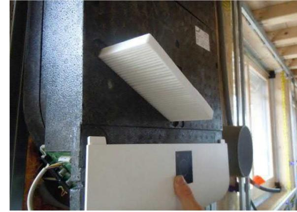
Le remplacement des filtres et le réglage du débit sont d'une **grande simplicité**.
