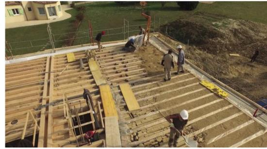
Mise en œuvre des rebuts de brique d'argile compressée en remplissage de plancher.
