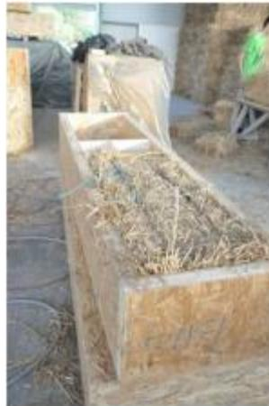
Fabrication des caissons de façade avec remplissage paille.
