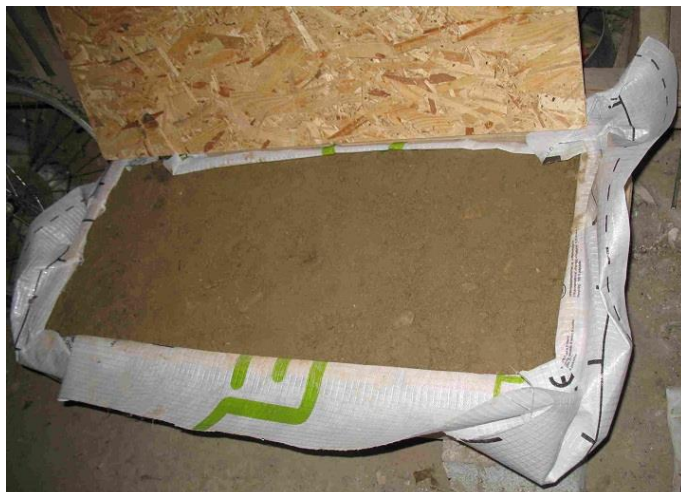
Caisson le 02/12/2015 avant sa fermeture
