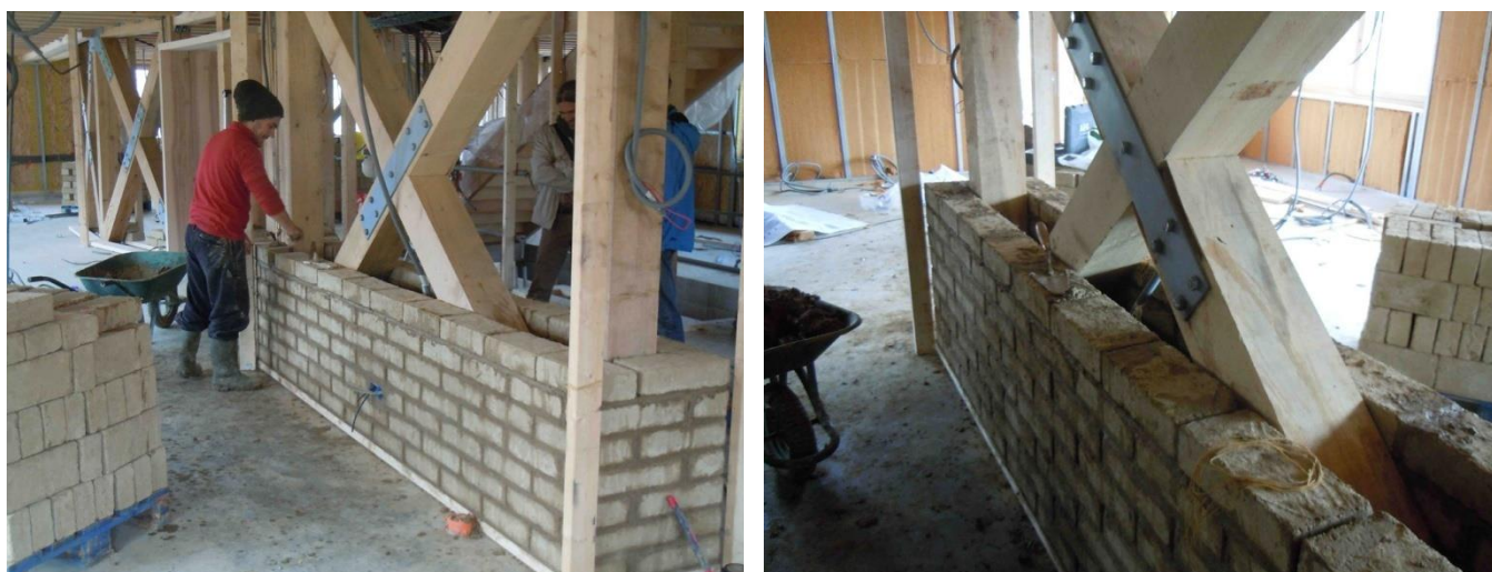
Fig. 2.10 : Parement en briques de terre crue des croix de saint André
