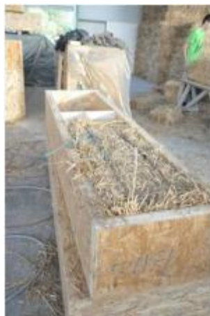
Préfabrication en atelier des caissons bois- paille Chantier : grutage d'un panneau préfabriqué
