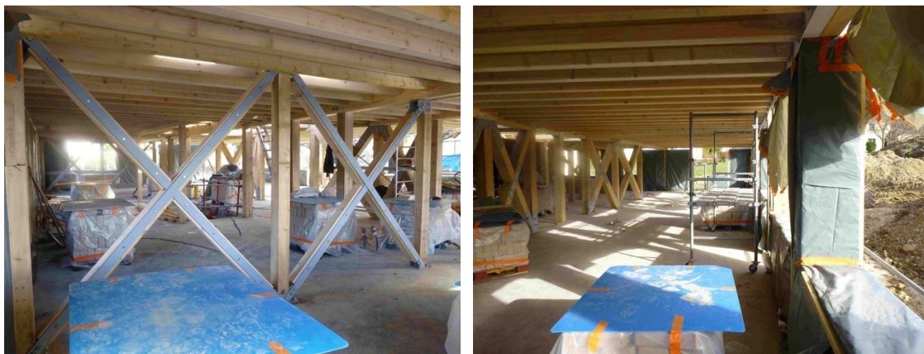
Fig. 2.7 : Photographies des croix de saint André du rez-de-chaussée
