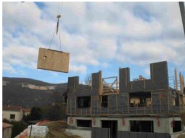
Préfabrication en atelier des caissons bois- paille Chantier : grutage d'un panneau préfabriqué
