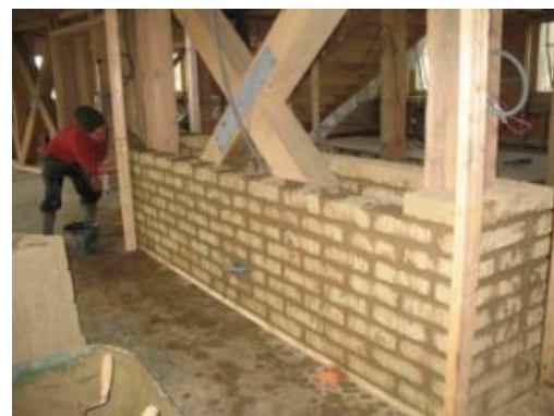
Chantier : réalisation du mur en briques de terre crue issue du terrain,
