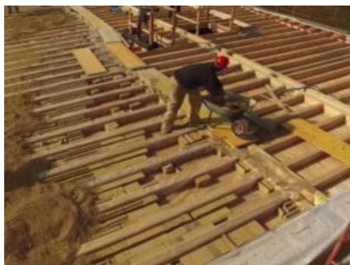
Chantier : remplissage en brique d'argile du plancher bois
