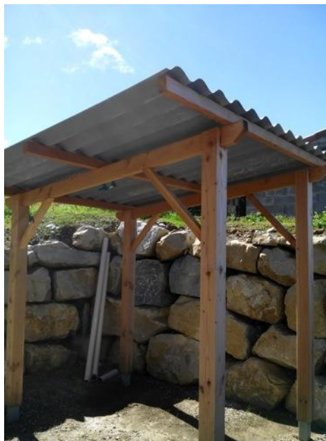
Photo 6. Tubes Radiello à l'extérieur sous l'abri vélo
