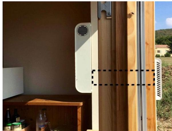
En pointillés, le conduit double flux traversant le mur.
