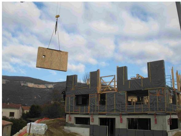
Chantier : grutage d'un panneau préfabriqué
