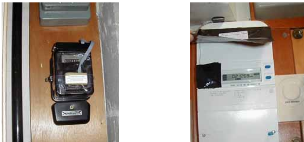
Figure 2.3 : Photographie de lecteurs optiques mécanique (gauche) et électronique (droite)
