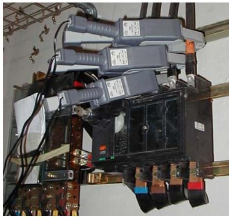
*Figure 1.10 : Pinces ampèremétriques utilisées pour le suivi des départs des tableaux électriques*
