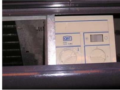
**Figure 1.5 : Photographie du panneau de commande usager des ventilo-convecteurs 2 tubes des bureaux (thermostat et vitesse ventilateur)**
