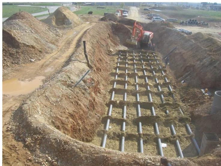
**Nappe inférieure des tubes du puits canadien. Profondeur : 2,8 m. Longueur : 40 m. Nombre de tubes : 6**
