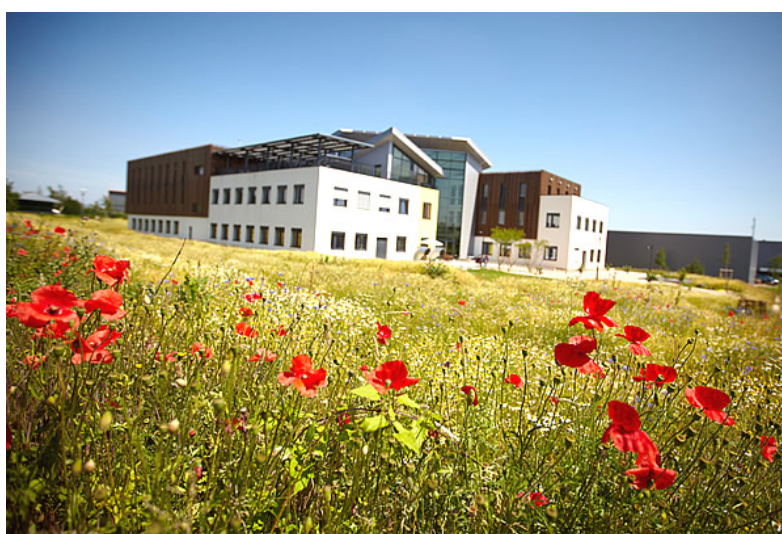
Figure 1.1: Vue Nord du bâtiment
