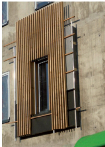
Figure 1.4 : Vue du bardage lors de la pose
