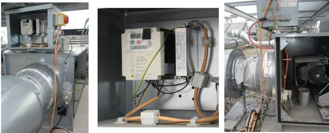
Figure 4.1.4 : Caisson d'extraction et boîtier de régulation
