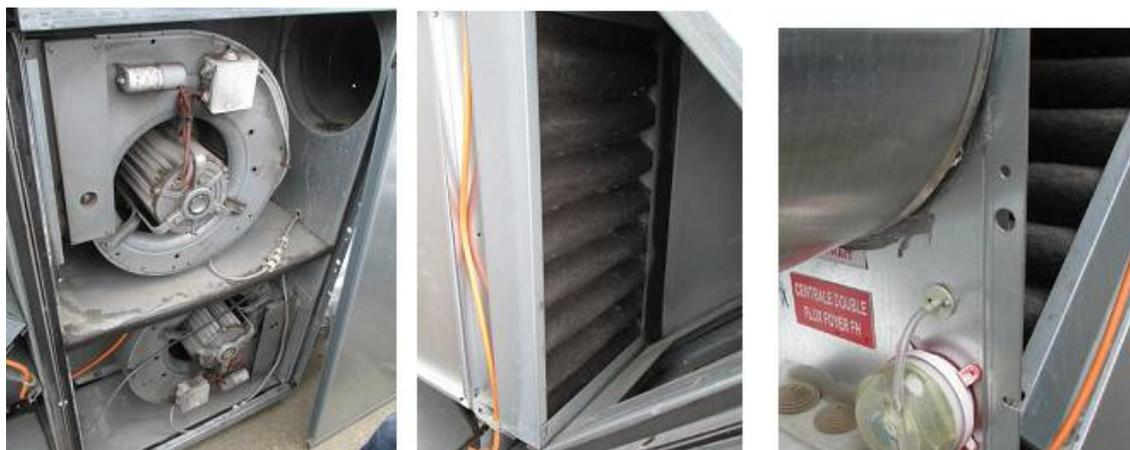
Figure 4.1.6 : ALDES ADF2A – Moteurs, filtre d’air neuf et filtre d’air extrait
