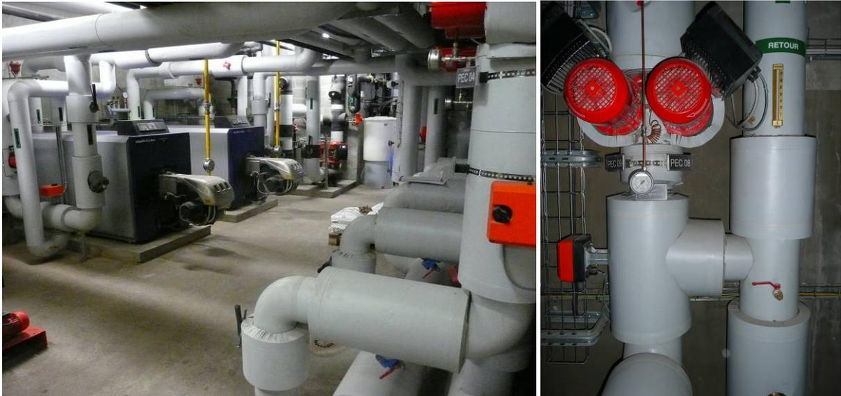
**Figure 5.3.4 : Isolation des tuyauteries et composants en chaufferie**
