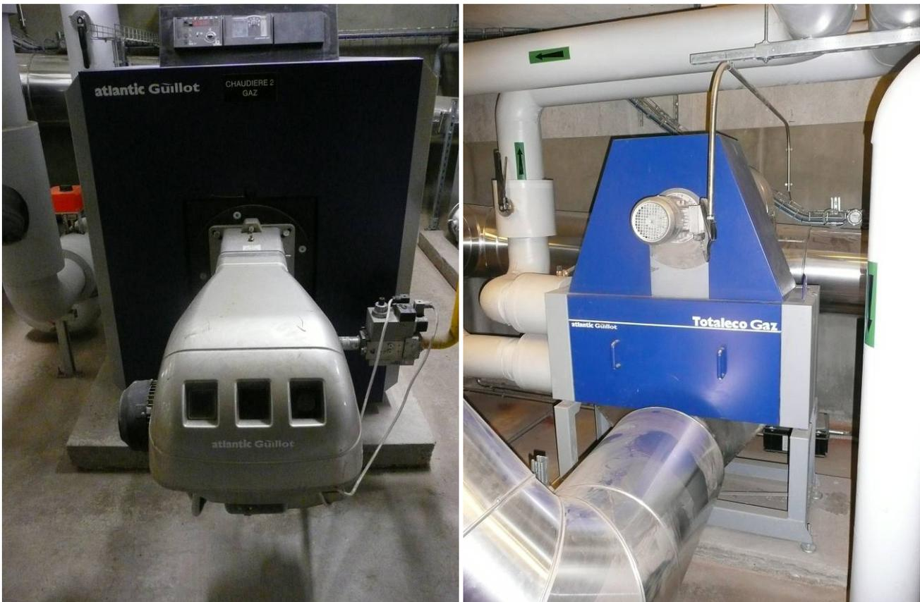
**Figure 5.1.2 : Chaudière gaz et récupérateur à condensation**
