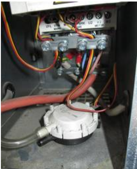
Figure 4.5.3 : Mauvais câblage électrique de la prise de pression
