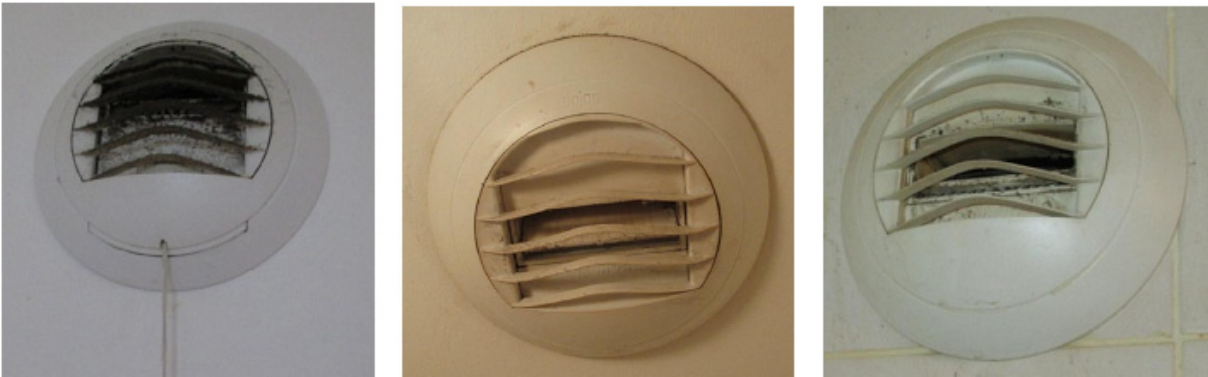
Figure 4.3.4 : Bouches d'extraction autoréglables : cuisine (bi-débit), WC (15m 3 /h), salle de bains (30 m 3 /h)
