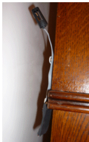
Figure A2.4 : Thermo-Hygromètre installé derrière une armoire
