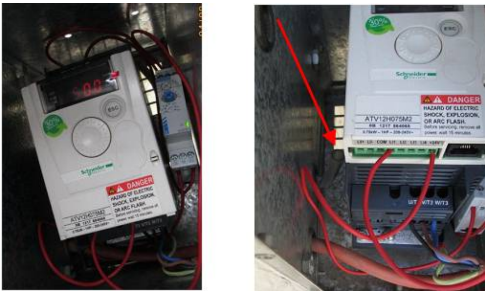
Figure 4.5.4 : Variateur de fréquence et minuterie (à gauche) et prise de pression non raccordée (à droite)
