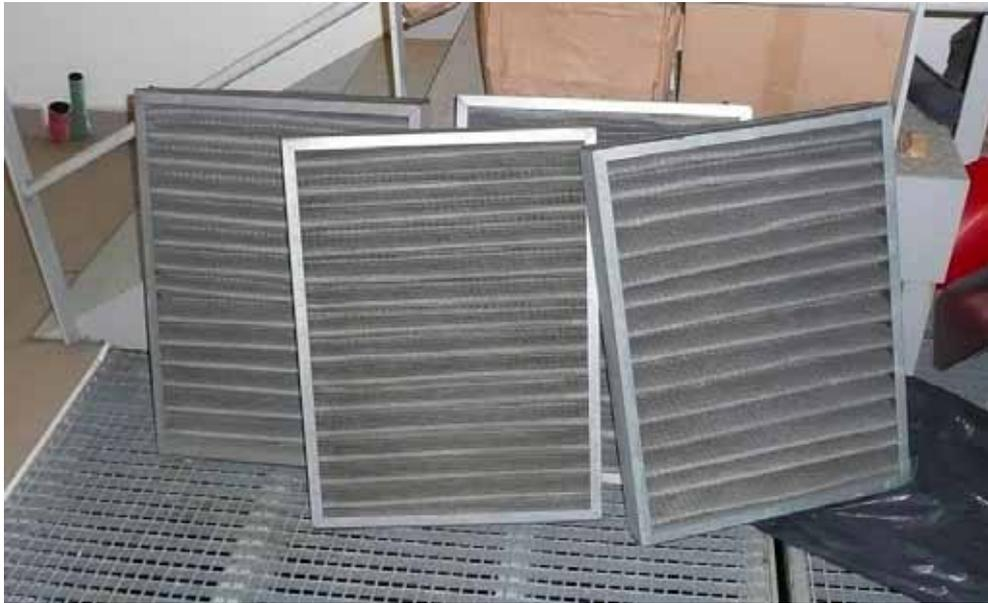
**Figure 7-20 : Filtres des caissons d'insufflation, en attente en chaufferie**
