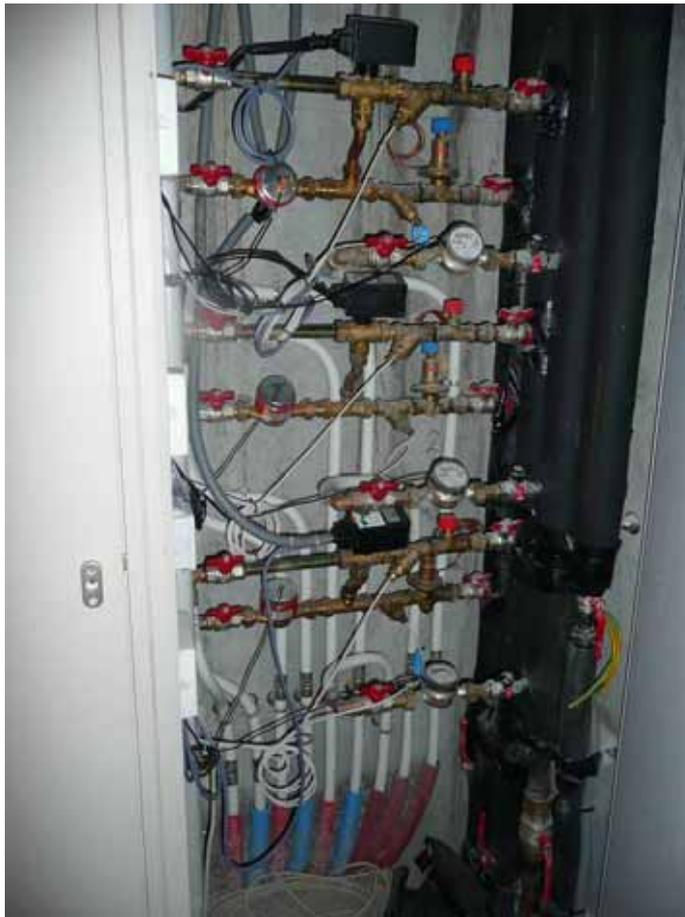
**Figure 5-17 : Composants pour la distribution du chauffage dans les placards techniques**
