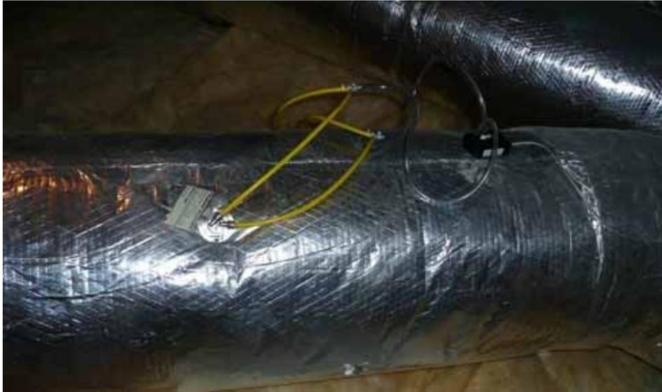
**Figure 4-5 : Tubes de Pitot utilisés pour la mesure des débits d'air**
