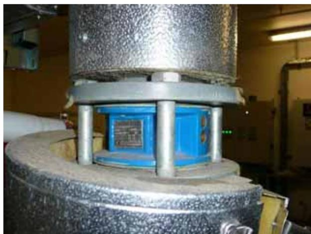
**Figure 5-3 : Clapet anti-retour à la sortie de la chaudière gaz**
