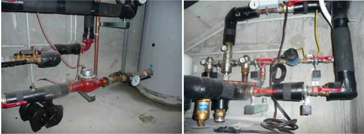
**Figure 10-2 : Discontinuité d'isolation des circuits de charges des préparateurs d'eau chaude (photo de gauche) et des circuits de bouclage (photo de droite)**
