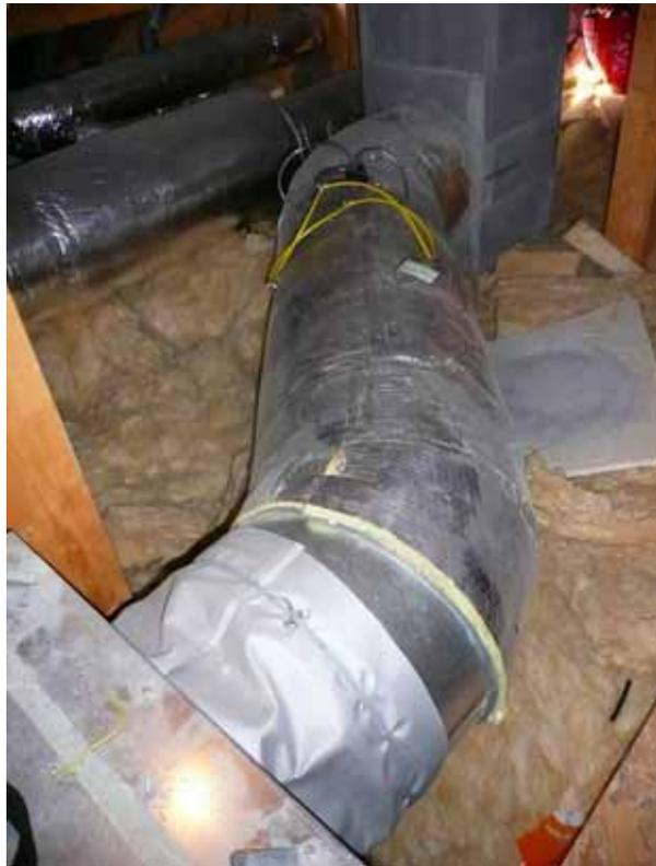
**Figure 4-9 : Manchettes souples utilisées pour le raccordement des conduits rigides aux groupes de ventilation**
