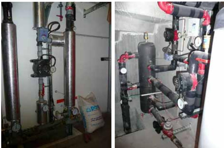
**Figure 10-1 : Manque d'isolation sur certains tronçons, coudes et corps de pompe**
