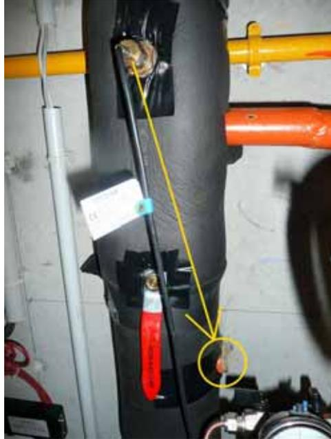
*Figure 5.3.5: Photographie du positionnement correct de la sonde de température retour du compteur de chaleur chauffage.*
