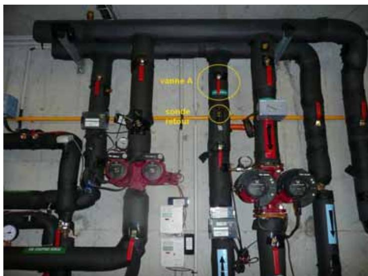
**Figure 5.3.4 : Sonde de retour du circuit de chauffage**
