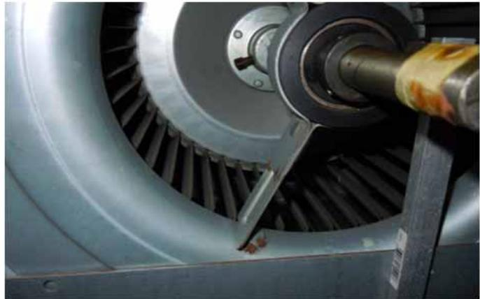
Figure 3.2-10 : Photographies illustrant le mauvais sens de rotation
