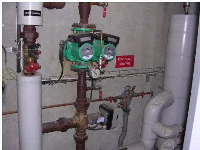
Figure 3.7 : Photographie de la pompe double de chauffage
