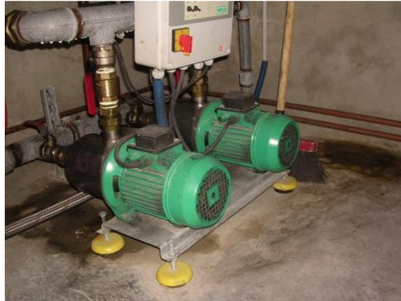
Figure 3.11 : Photographie du module de surpression
