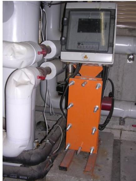
*Figure 3.10 : Préparateur ECS de la chaufferie*
