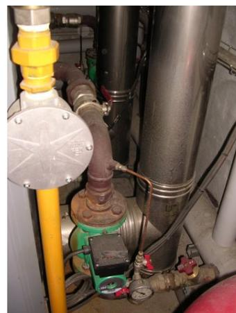
La consommation des pompes des chaudières représente 14,3 % de la consommation totale (chaufferie + local solaire) avec une consommation annuelle de **2 390 kWh/an (1 600 kWh/an pour la pompe chaudière n°1 et 790 kWh/an pour la pompe chaudière n°2)** soit **186 €H.T/an**.
