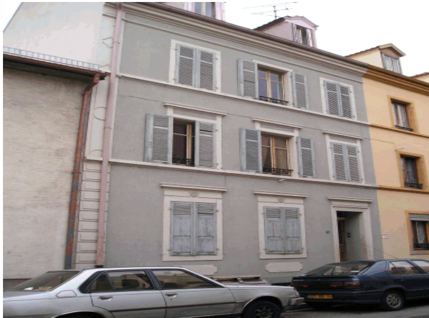
Figure 7.1 : Immeuble typique de la rue des Vosges à Mulhouse
