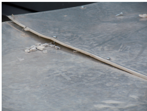
Figure 4 : assemblage de conduits de ventilation « très peu étanches »
