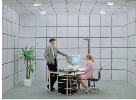
Figure 2.2 : Exemple d'installation performante d'éclairage d'un bureau (bas niveau d'éclairage de la pièce et appoint par lampe de bureau)
