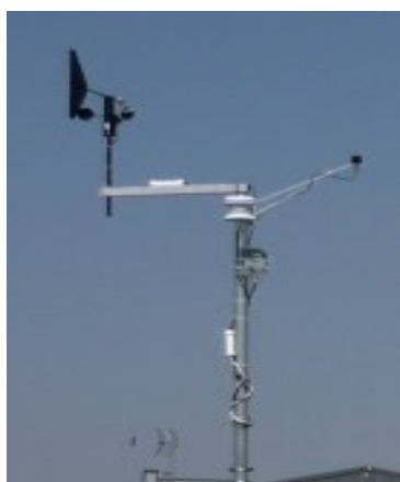
Station météo mise en place sur le toit du bâtiment
